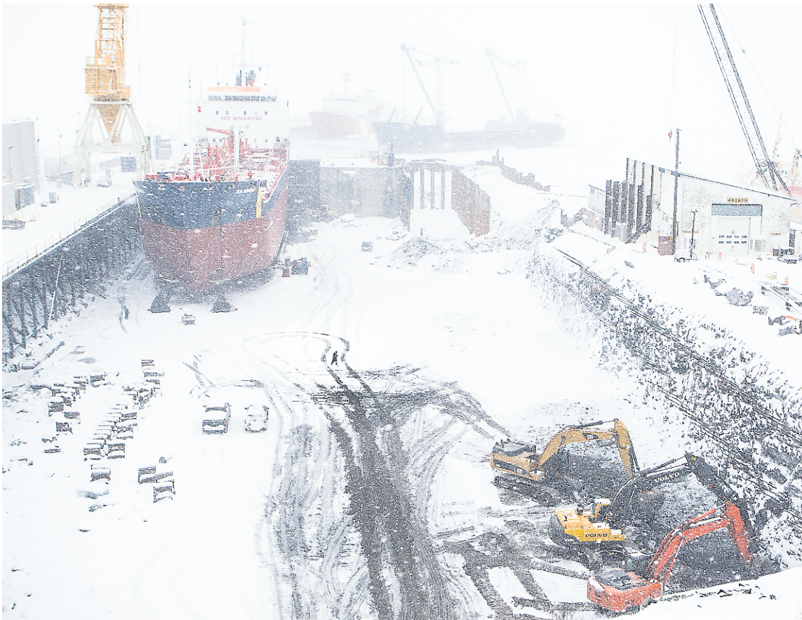
La cale sèche du Groupe maritime Verreault aux Méchins aura bientôt doublé de largeur et pourra accueillir les bateaux de tout tonnage.
