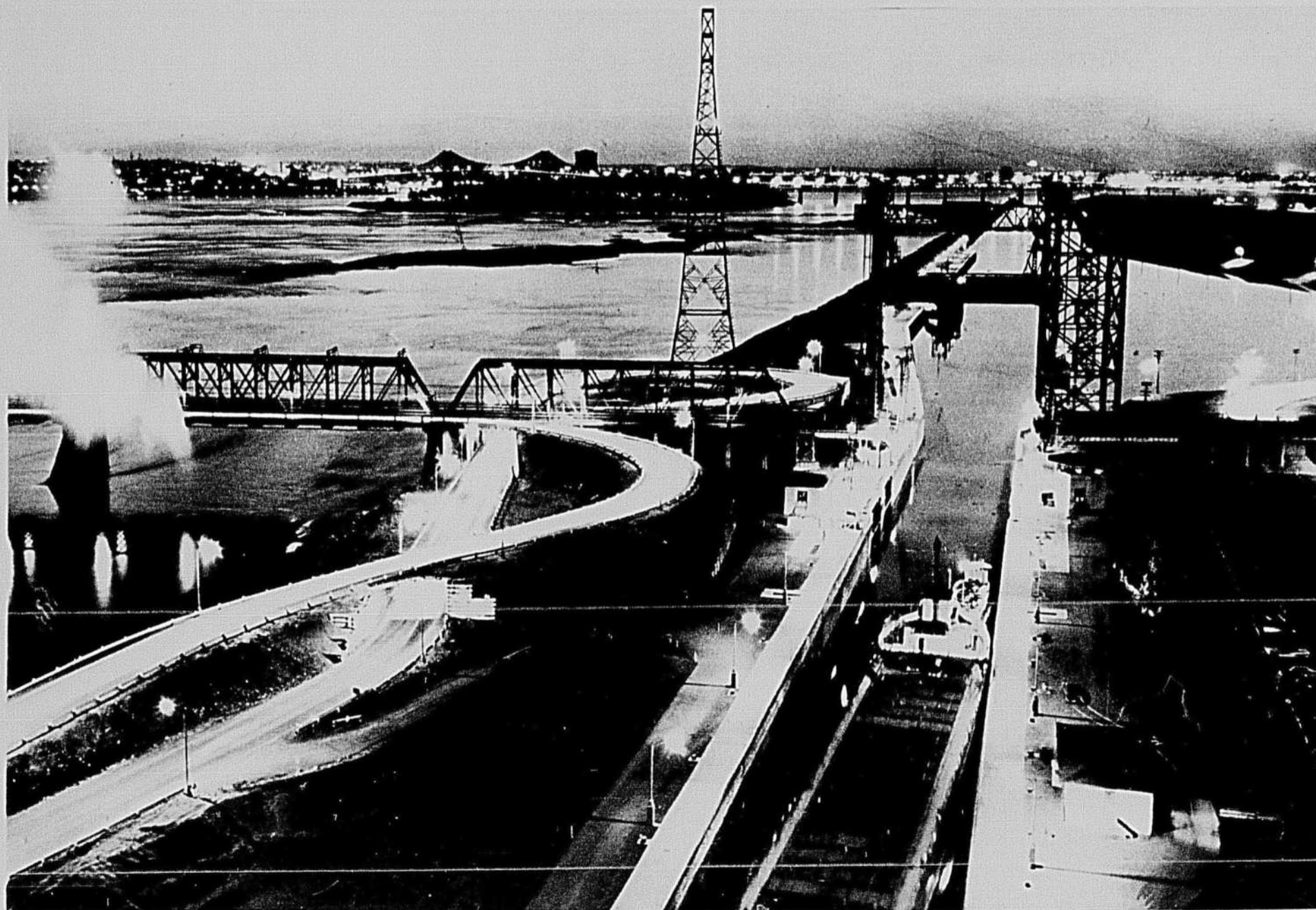
Le complexe de l'entrée montréalaise de la Voie maritime. À droite, une section du pont Victoria a été haussée pour laisser passer un navire.
