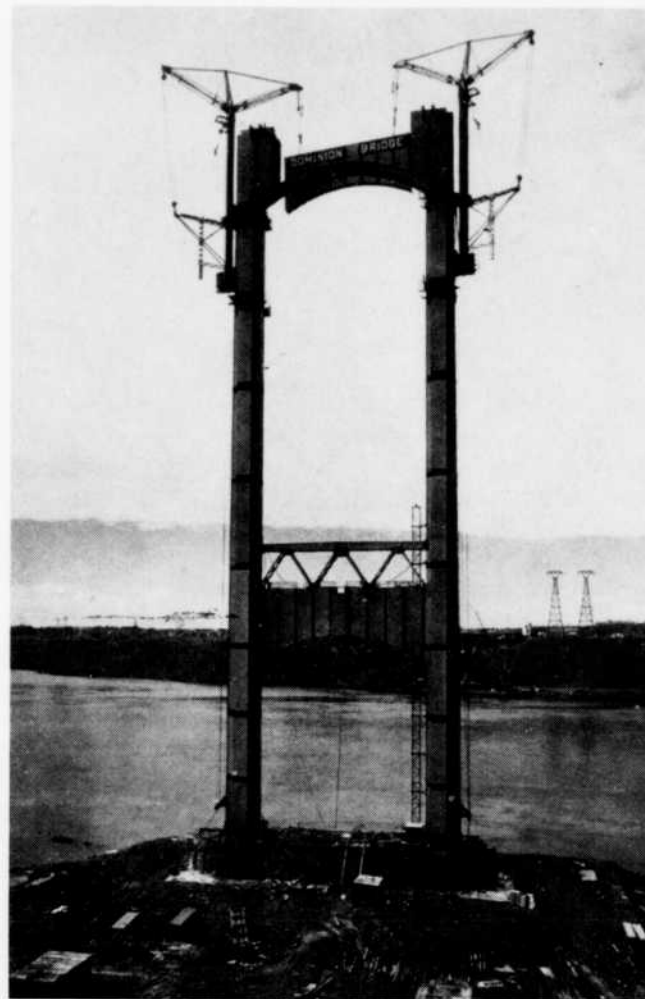
Figure 4 — Montage d'un pylône
