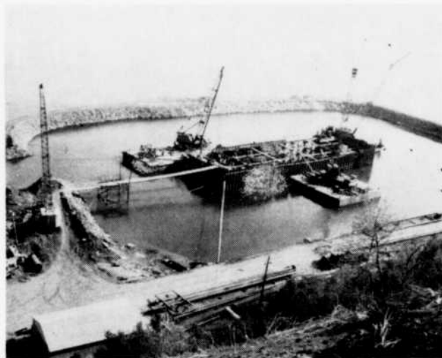
Figure 2 — Batardeau du pilier nord
