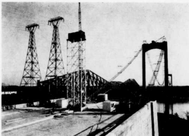
Figure 8 — Passerelles de travail regardant vers le sud.
