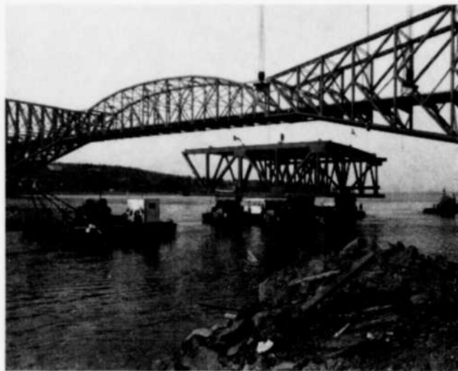
Figure 9 — Tronçon de structure remorqué pour être hissé en place.
