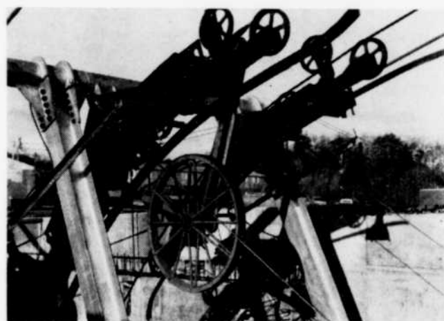
Figure 5 — Au droit d'un ancrage, support des câbles de service pour la roue servant à tisser un câble porteur.
