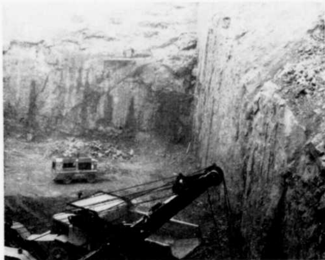
Figure 1 — Excavation de roc du côté nord
