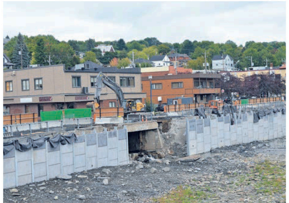
Des coûts supplémentaires de 431 000 $ sont à prévoir en raison du roc qui est plus profond que prévu à certains endroits. (Photo L'Éclaireur-Progrès - Archives)
