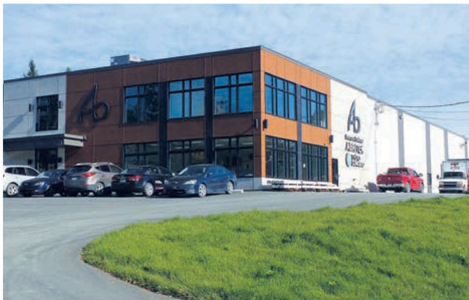
Abritek investira 2 M$ dans l'agrandissement de son usine. (Photo Ville de Saint-Georges)
