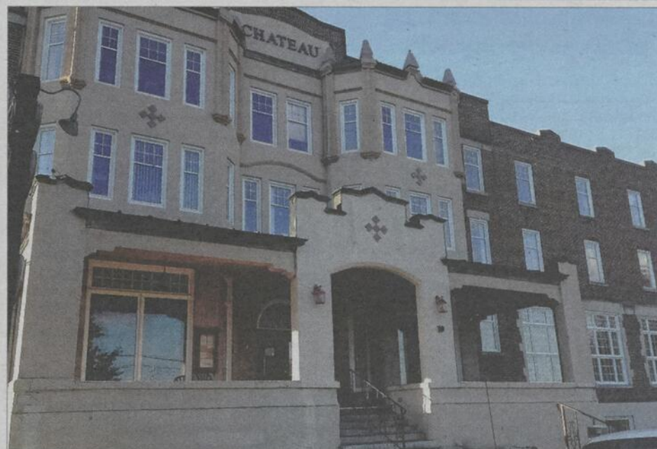
L'édifice du 10 rue King abrite le nouveau bureau satellite de la Chambre de commerce et d'industrie Beauharnois-Valleyfield. TC MÉDIA-MARIE-CLAUDE PILON
