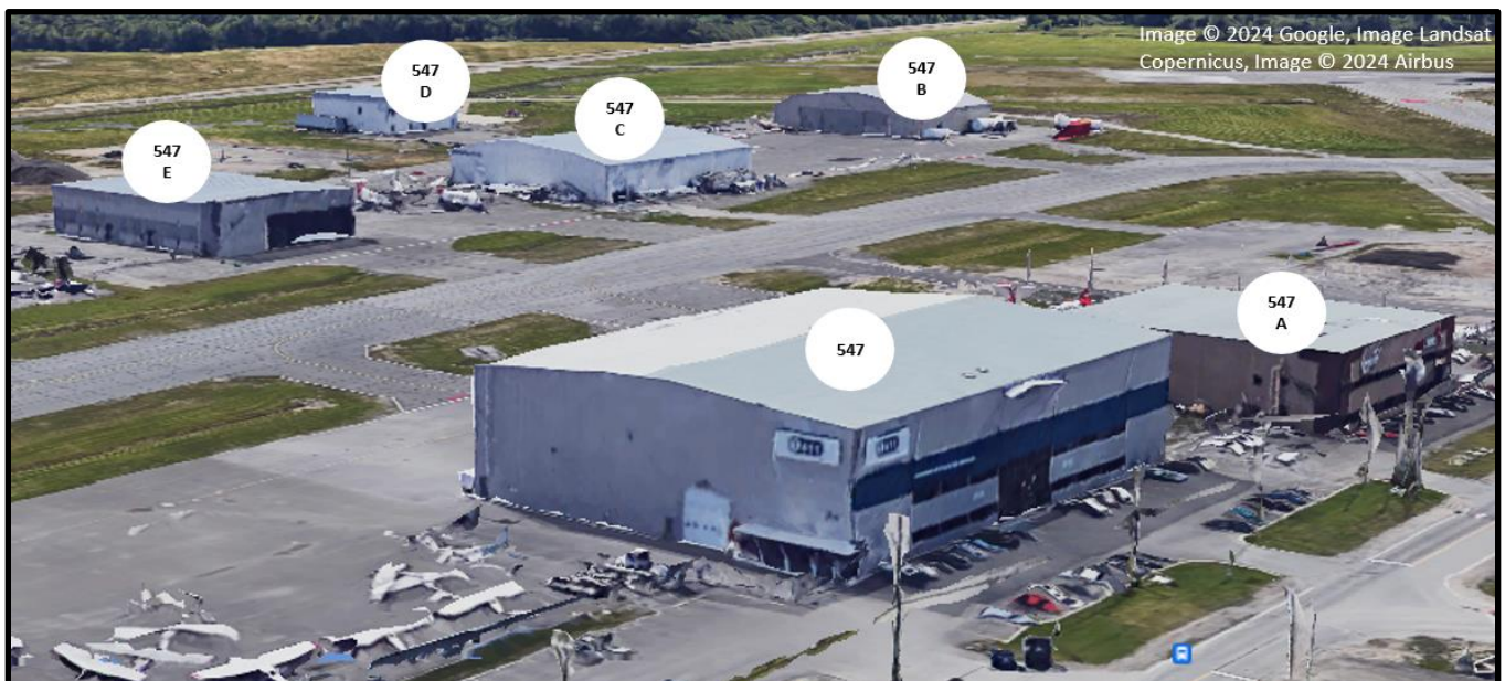
Figure 25 : Ensemble de bâtiments privés
