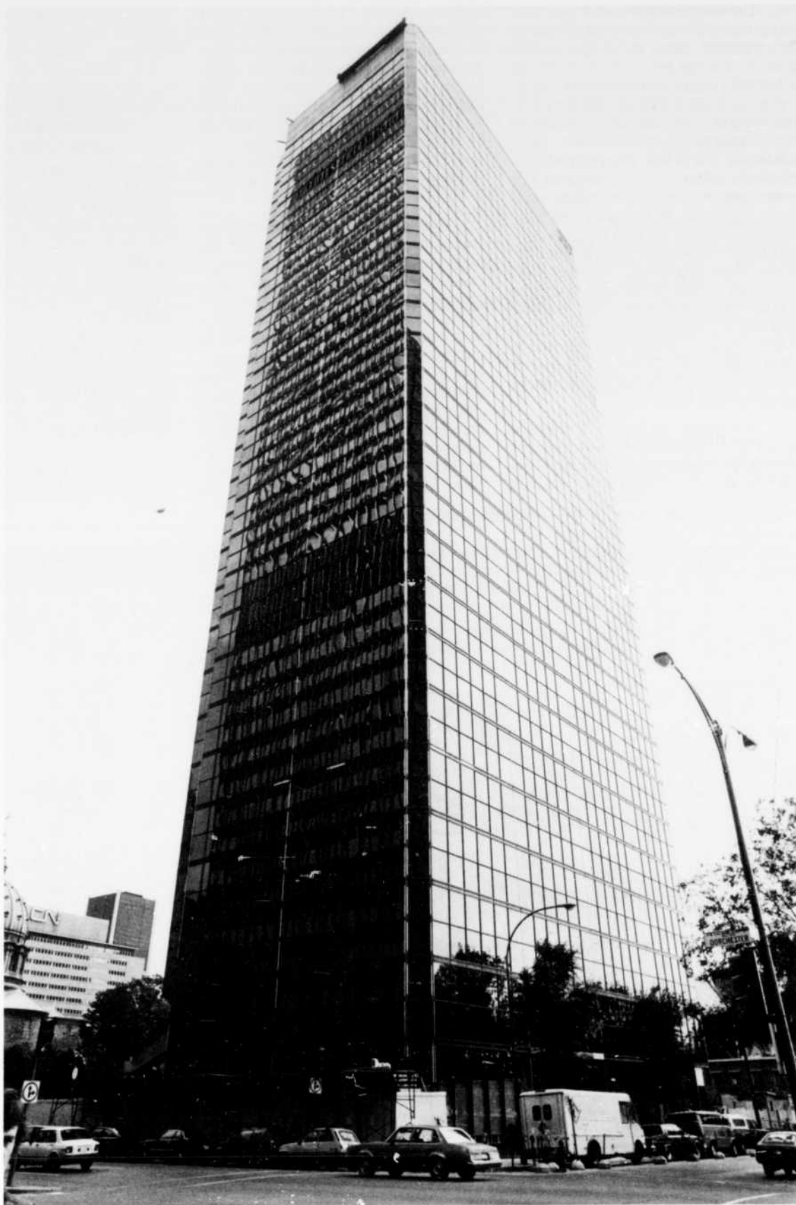
L'édifice La Laurentienne à Montréal où un béton structural de 120 MPa (à 1 an) a été utilisé lors de la construction d'une colonne expérimentale en 1984.
