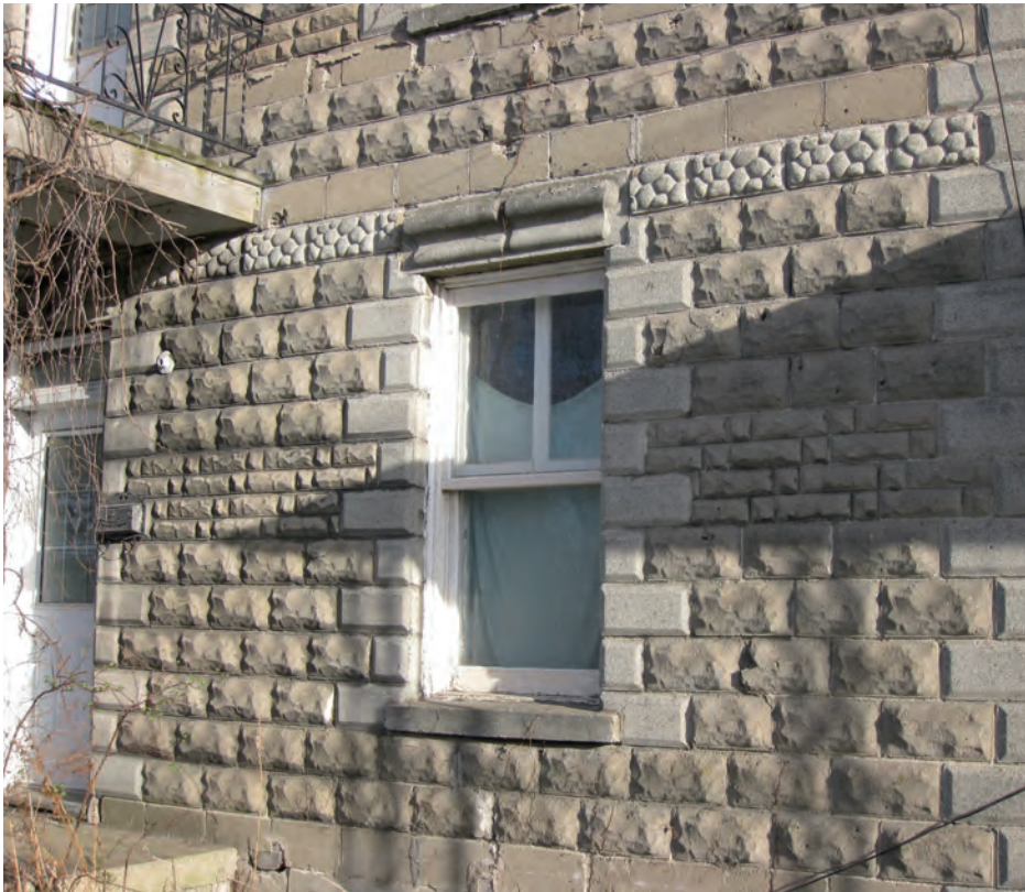
Les blocs de béton texturé imitent les tailles de pierre, mais offrent aussi de nouvelles textures. Photos : François Varin
