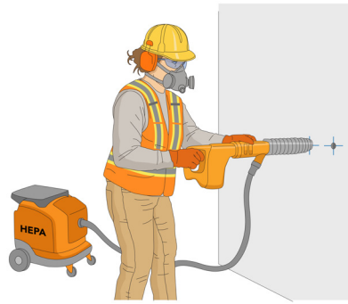
Figure 8 : Perceuse munie d'un système d'aspiration avec filtre HEPA
