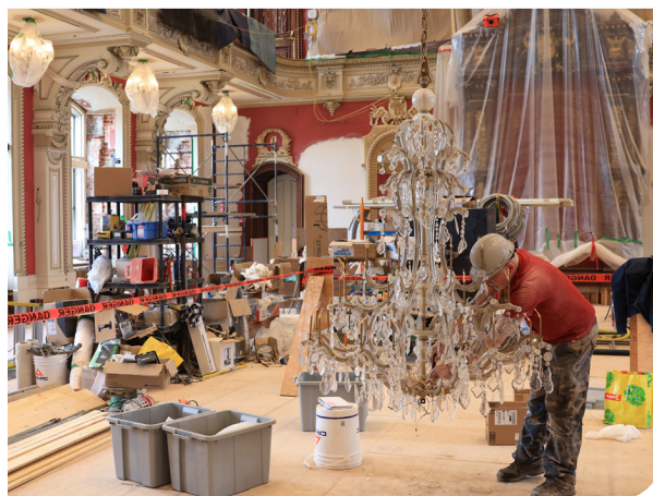
Travaux dans la salle du Conseil législatif.
