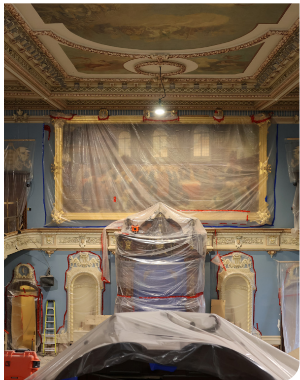
Travaux dans la salle de l'Assemblée nationale.
