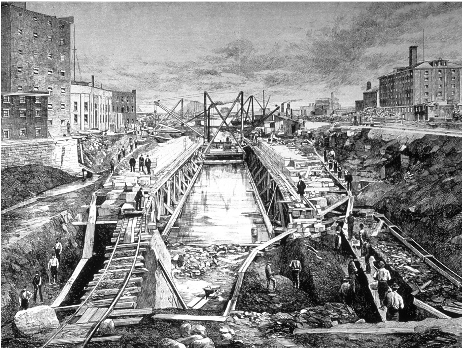
Construction du canal de Lachine, chantier à l'école Saint-Gabriel. (Lachine Canal Enlargement. Work at the St. Gabriel Locks Illustrated News 1877.)
