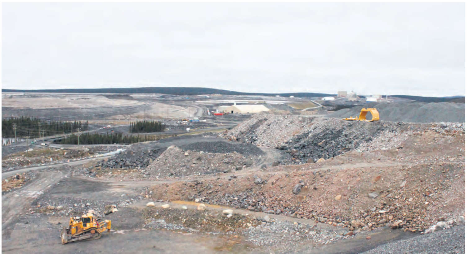
Les derniers travaux majeurs de la phase II de la mine du lac Bloom ont été terminés.
