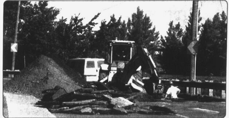
La circulation sera perturbée jusqu'à la mi-septembre sur la rue Champlain en raison des travaux correctifs au régulateur des eaux usées de la rue Saint-Hubert.
