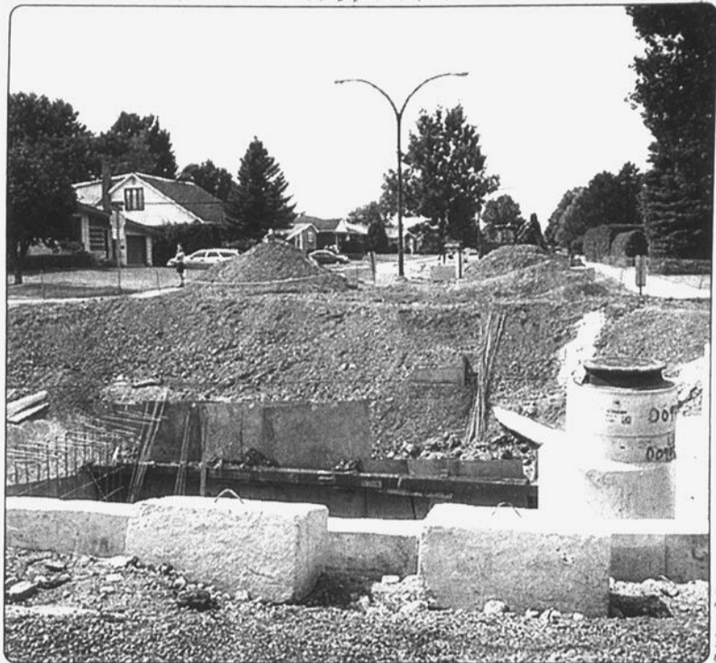
Dans moins de trois semaines, les mégatravaux d'installation d'un collecteur pluvial sous la rue Latour devraient être parachevés dans le secteur Saint-Jean.
