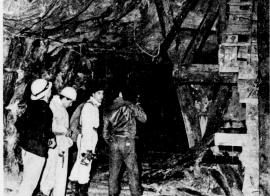
A peine entrés dans la mine, de vieux étais menacent de tomber sur la tête des spéléologues; de gauche à droite, Pierre Fontaine, Roger Delorme, Roger Bergeron et Yvon Charpentier.
