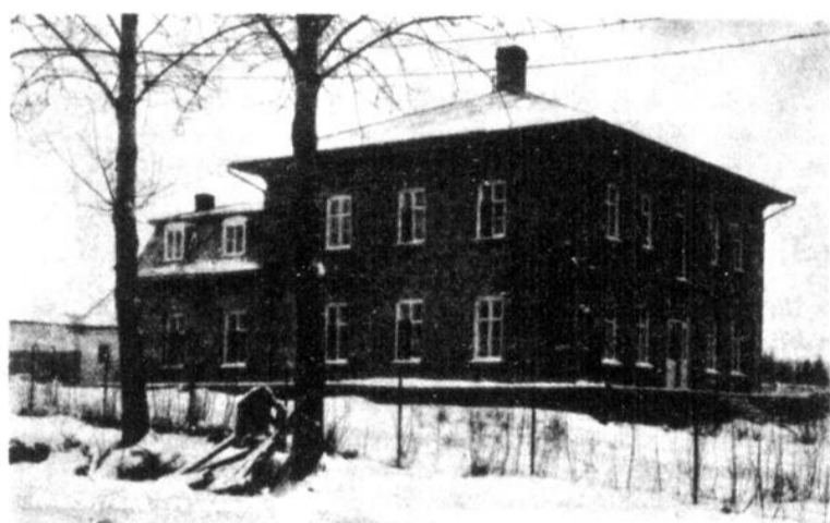
Presbytère actuel, construit en 1901.
