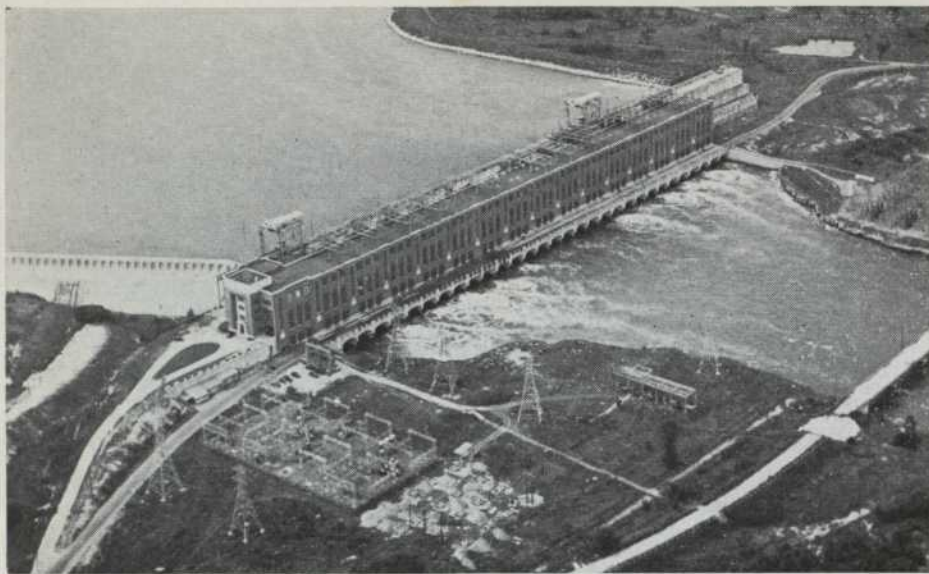
La première centrale de Beauharnois, longue de 1,100 pieds. Commencée en 1929, elle entrain en exploitation en 1932.
