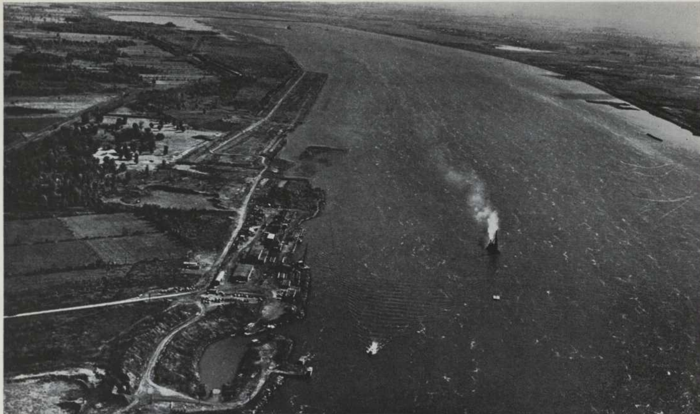
Le canal de Beauharnois. Au premier plan gauche, un bassin de sédimentation.
