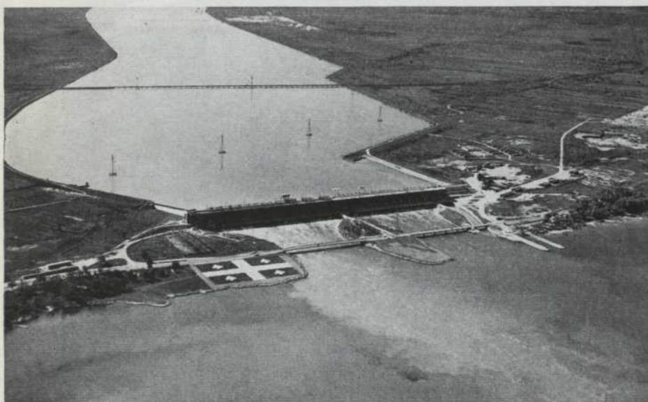
La deuxième centrale de Beauharnois portait la longueur totale de l'usine à 2,100 pieds et sa puissance à 1,425,000 chevaux.
