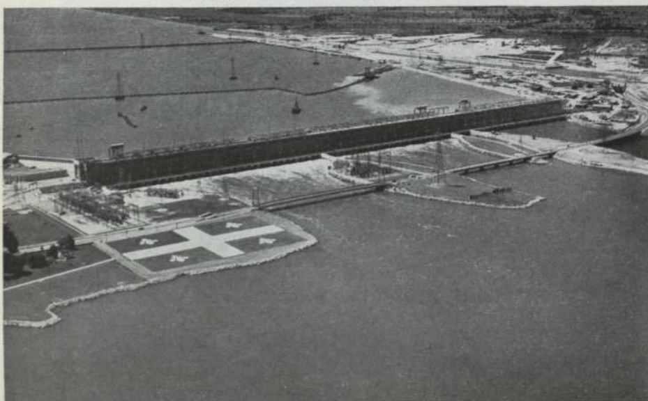
Maintenant terminée, la centrale a plus d'un demi-mille de long et une puissance de 2,161,000 chevaux provenant de ses 36 groupes générateurs.
