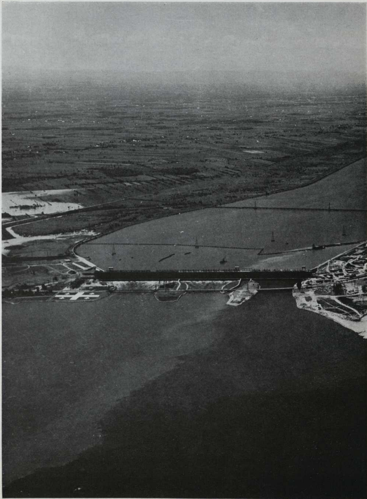
Vue générale du canal d'aménée à Beauharnois, illustrant son double emploi: la navigation et la génération de l'électricité. A gauche, la centrale; à droite, les écluses de la voie maritime.
