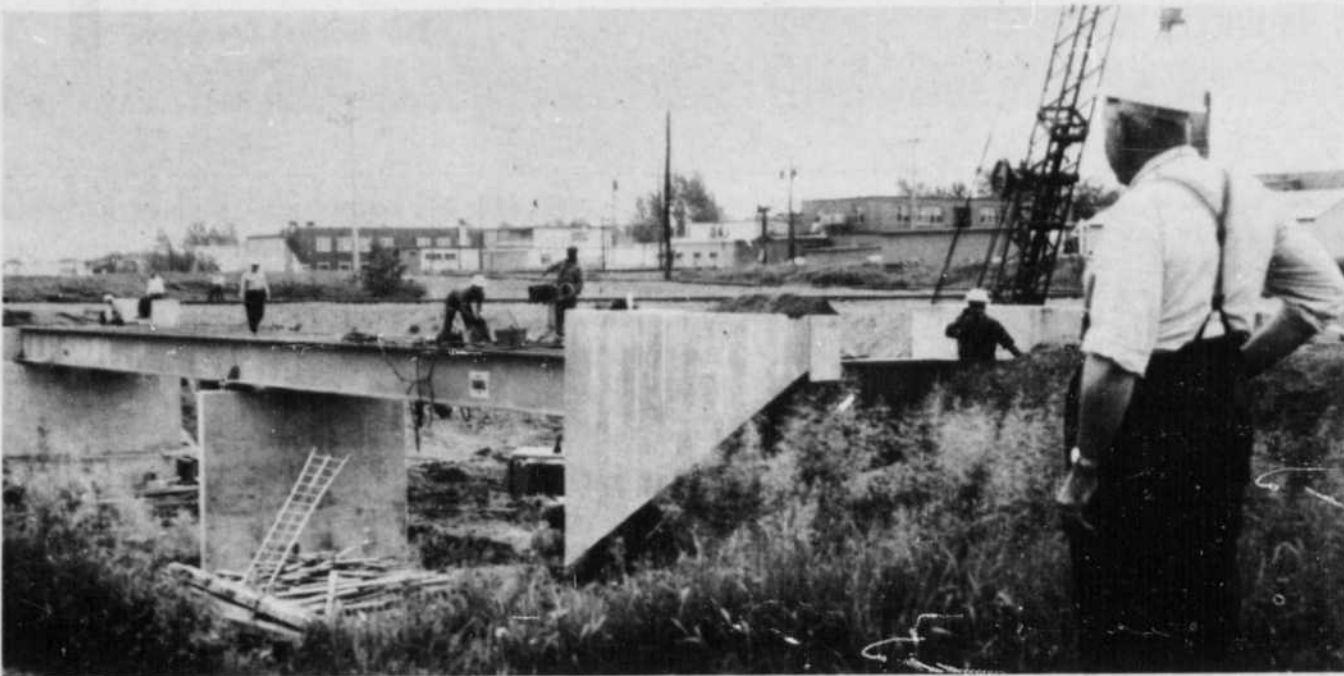
LE SURINTENDANT des travaux, M. Rosaire boulevard Davis. Selon M. Baril, les travaux de Baril, surveille le rivetage des poutres d'acier au vront se terminer vers la fin de septembre. chantier de construction de la voie inférieure du
