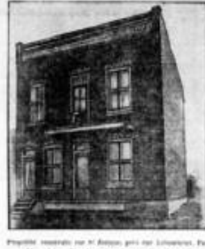
Propriété construite sur St-Armand, près des Linteaux, Parc Champlain. (Pho. L. B. Paré, 117 Mont-Royal Est, sans apprêt.)
