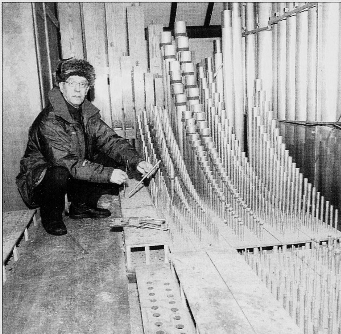
Le vice-président de la Fabrique Notre-Dame-de-la-Paix, Pierre Lavoie (aussi à la une), montre les dommages faits à l'orgue de l'église Saint-Laurent.
