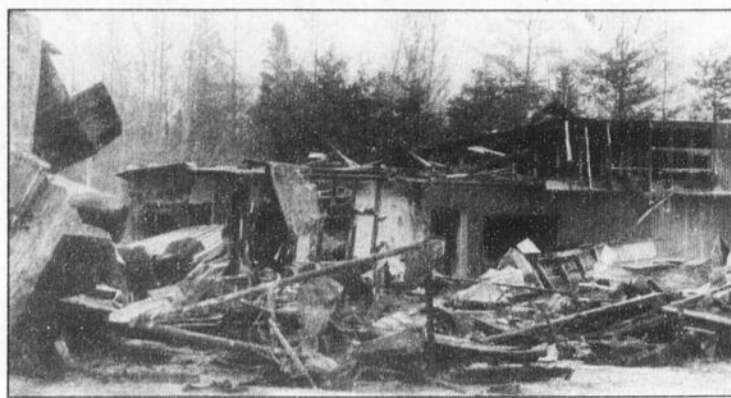
PERTE TOTALE - La bâtisse propriété de la SADEC abritant Sport DR et l'entreprise PLP a été rasée par les flammes.
