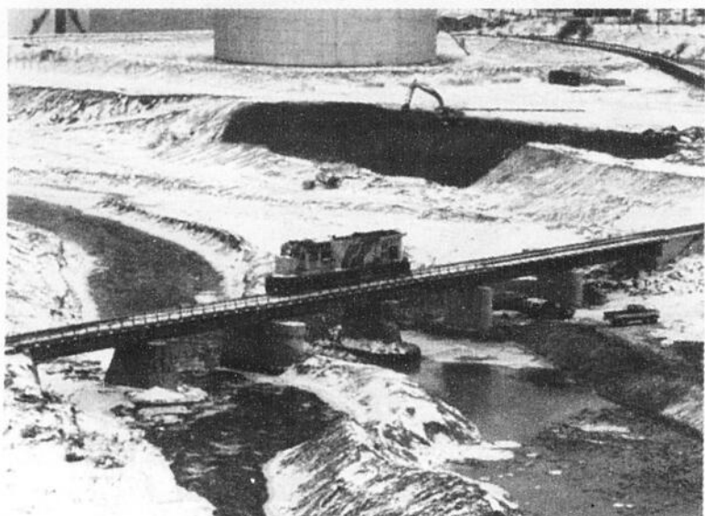
PASSAGE - Hier matin, une locomotive de Roberval-Saguenay s'est avancée pour la première fois sur le nouveau pont enjambant la rivière à Mars tout près de l'usine de filtration de La Baie. (Photo Rocket Lavoie)
