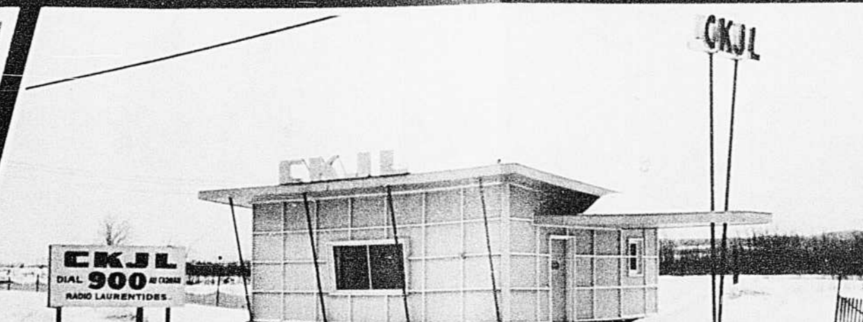
Transformateur de la Station C.K.J.L. Radio Laurentides
