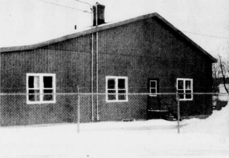
(Photo La Tribune par Bertrand Gosselin) L'ancien édifice de la Robin Hood sert actuellement d'entrepôt aux divers départements municipaux.
