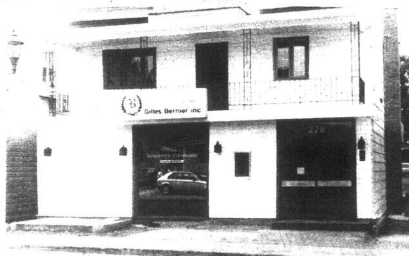
Au 226, rue Lafontaine, Rivière-du-Loup Rénovation extérieure
