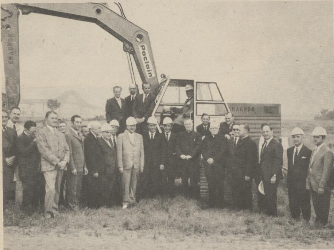
Plusieurs invités s'étaient déplacés vendredi dernier afin de participer à cette cérémonie d'inauguration des travaux de construction d'aqueduc et d'égout dans la ville de Bécancour.
