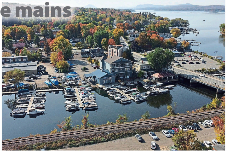
Un vent de changement soufflera bientôt sur Magog Marine, une entreprise implantée à Magog depuis 35 ans. (Photo gracieuse)
