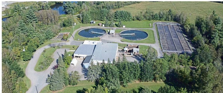
D'importants travaux auront lieu à cette station d'épuration de la rue de Hatley. Toutes les eaux usées de Magog seront bientôt traitées à cet endroit. (Photo gracieuseset)
