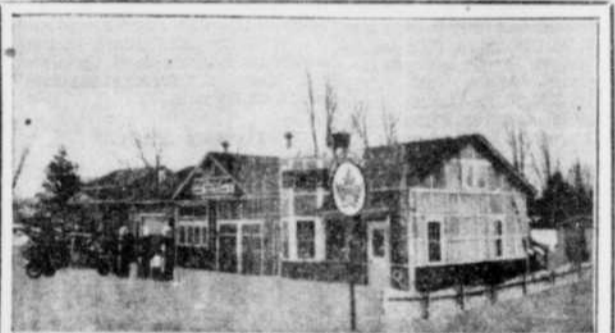
Ci-dessus, le garage Fontaine, rue Daigneault où, en plus d'un atelier de réparations, on vend des pièces d'autos et des accessoires électriques.
