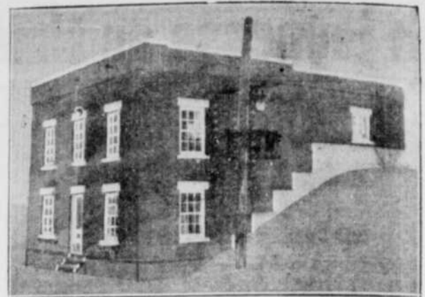
Construction moderne de l'usine de filtration d'Acton Vale.
