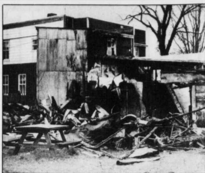
(Flageol Photo — Roméo Flageol) Deux remises ont été entièrement détruites par un incendie survenu lundi vers 2h 15, au 448 Notre-Dame à Cap-de-la-Madeleine.
