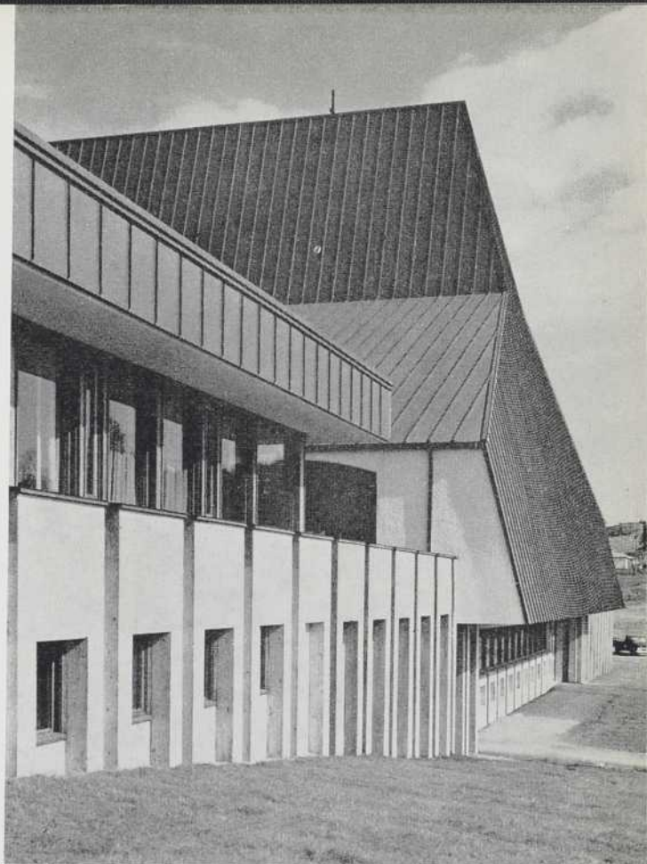
vue fuyante de la façade latérale prise à la hauteur du presbytère
