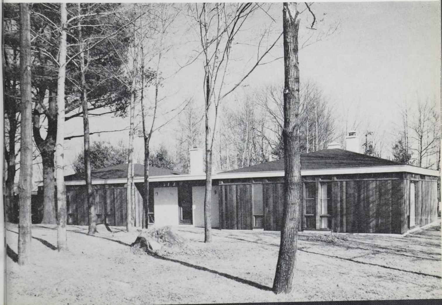
Vue de la façade, prise de la route d'accès
