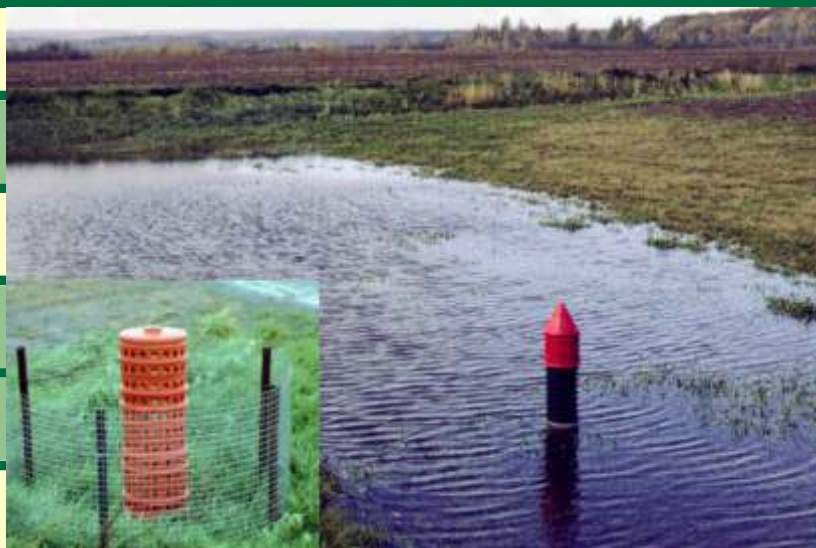
Bassin de sédimentation avec avaloir
