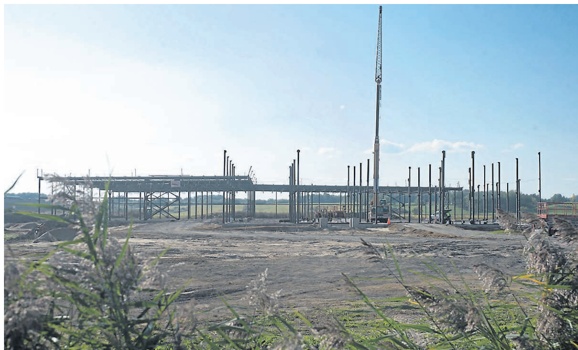
La construction d'une usine de production de cannabis thérapeutique est bien amorcée à Louiseville.
