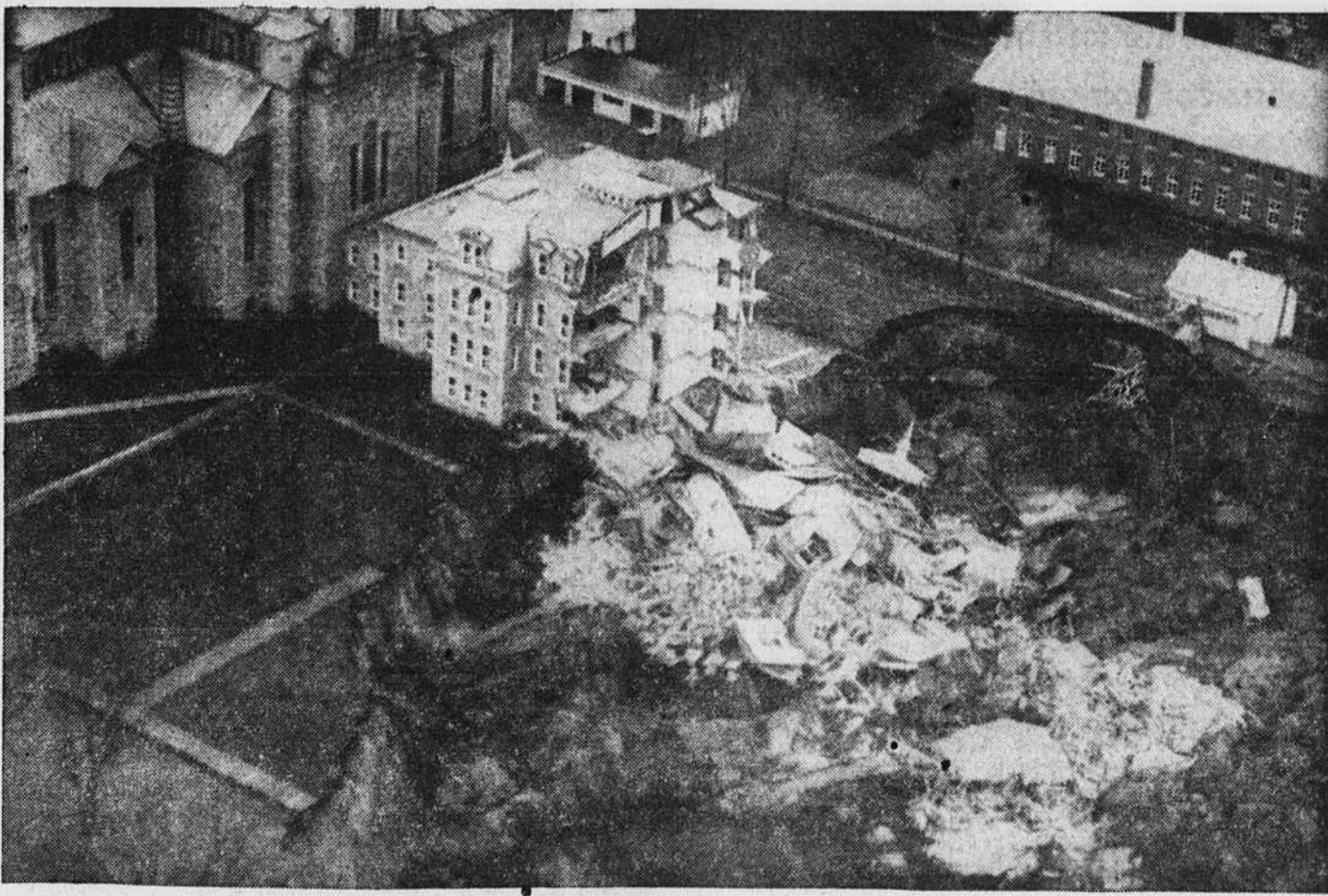
Les trois quarts de l'évêché se sont effondrés. Aujourd'hui cet amoncellement de pierres et de briques a disparu dans la glaise.
