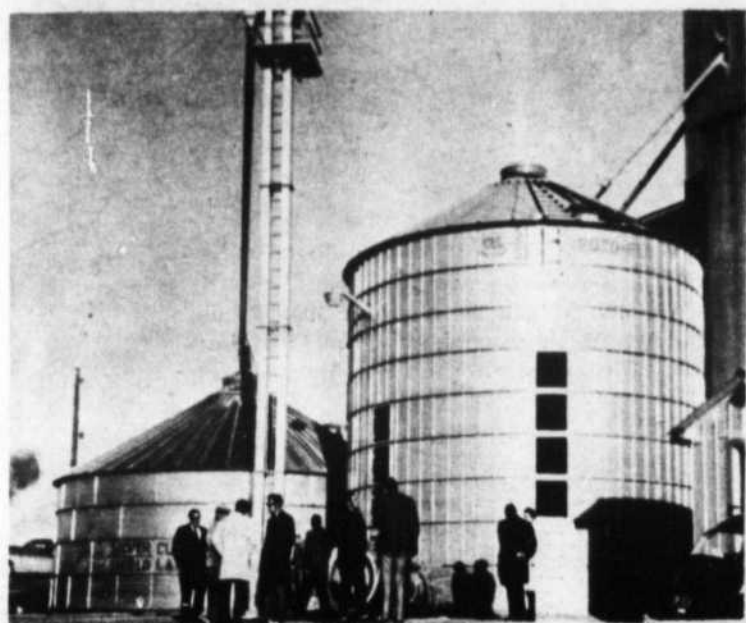
Une vue d'ensemble du plan du séchage de maïs-grain greffé aux installations déjà existantes à Notre-Dame du Bon Conseil.
