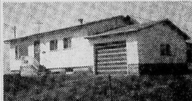
St-Anaclet, bungalow 34x24, construction récente, 2 chambres à coucher, terrain de 6,138 p.c. Denise Gendreau, 724-6130. 722-7695.
