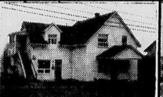
Rimouski, rue Tessier. Cottage 1 1/2 étage. 2 logements, extérieur rénové.
