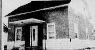
Rue St-Robert, près de Rouleau. Cottage 5 chambres à coucher, bon terrain aménagé. Georges Gendreau, 724-6130. 722-7695.
