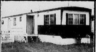
Rivière-Hâtée, camping Laviole. Maison-moblie "General Leader" 62'x12'. Finition extérieure en aluminium. Entrée électrique.
