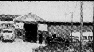
Rimouski, rue Ste-Odile. Commerce d'excavation et de terrassement.
