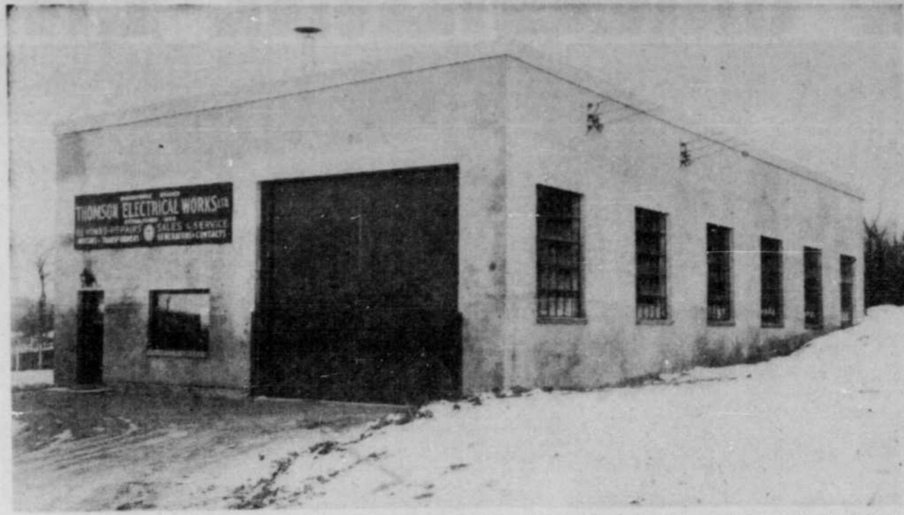
L'usine de la Thomson Electrical Works Ltd est une construction à toute épreuve, finie en ciment et en béton armé. On note la série de fenêtres assurant une abondante provision d'éclairage, la vaste porte destinée aux camions transportant les pièces ou appareils à vendre ou à réparer ainsi que, à gauche, la porte d'entrée des bureaux.
