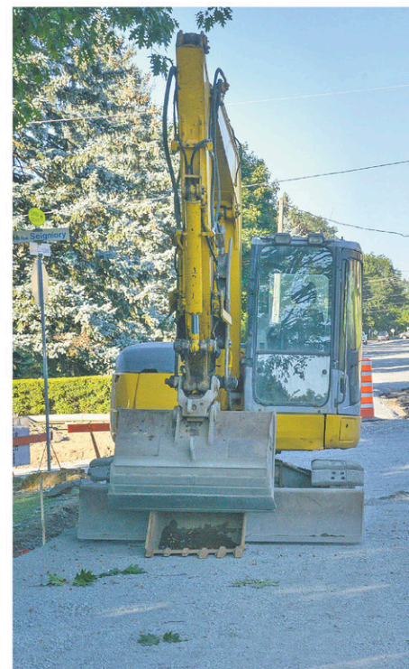
La rue Campbell faisait partie des rues à prioriser. Les travaux ont été effectués cette année. Photo: Archives
