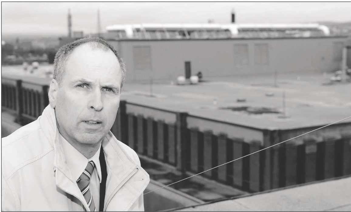
Le Cégep de Sherbrooke souhaite obtenir une certification LEED pour l'exploitation et la maintenance de ses bâtiments. Ci-dessus, on aperçoit le directeur du service des équipements du Cégep de Sherbrooke, Jean Lussier et, au loin, des équipements installés sur le toit du Cégep, qui servent principalement à réchauffer l'air avant qu'il n'entre à l'intérieur.
