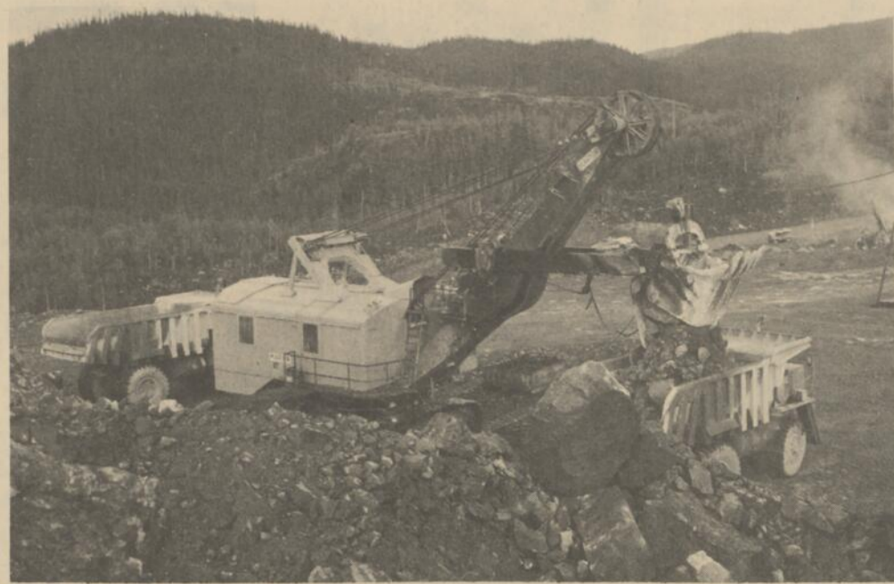
SEIZE CAMIONS de 50 tonnes à benne d'aluminium travaillent jour et nuit au barrage Outardes 4 de l'Hydro-Québec qui fait partie du complexe hydroélectrique géant (6,000,000 de kilowatts) de Manicouagan-Outardes. Les bennes sont en alliage Alcan 745 et pèsent cinq tonnes de moins que les bennes conventionnelles de cette dimension. On croit que ce sont les plus grandes du genre. La pelle mécanique arache sept verges cubes par "bouchée". Photo Alcan 65-00156
