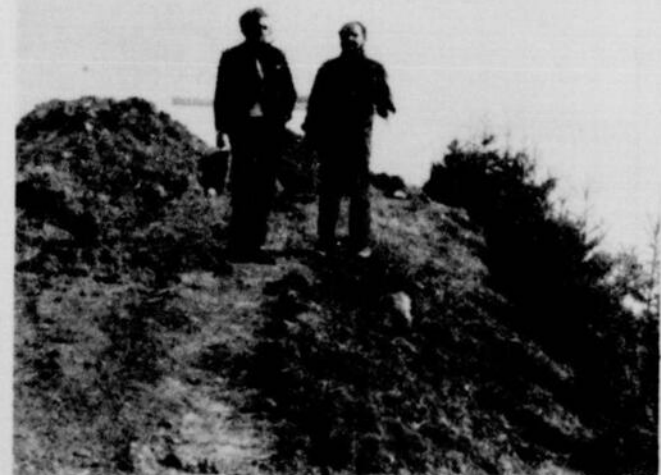
Jean-Louis Le Saux, le propriétaire du Centre récréatif Mont Laval, est ici accompagné du directeur de l'école de ski Werner Nydegger. Ils surveillent l'installation du TBar.
