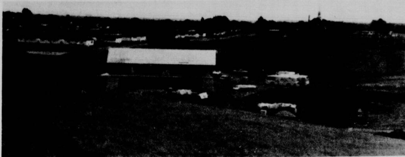
Le chalet "AU PIED DE LA PENTE DOUCE" est en construction présentement. Il pourra accueillir 500 personnes.
