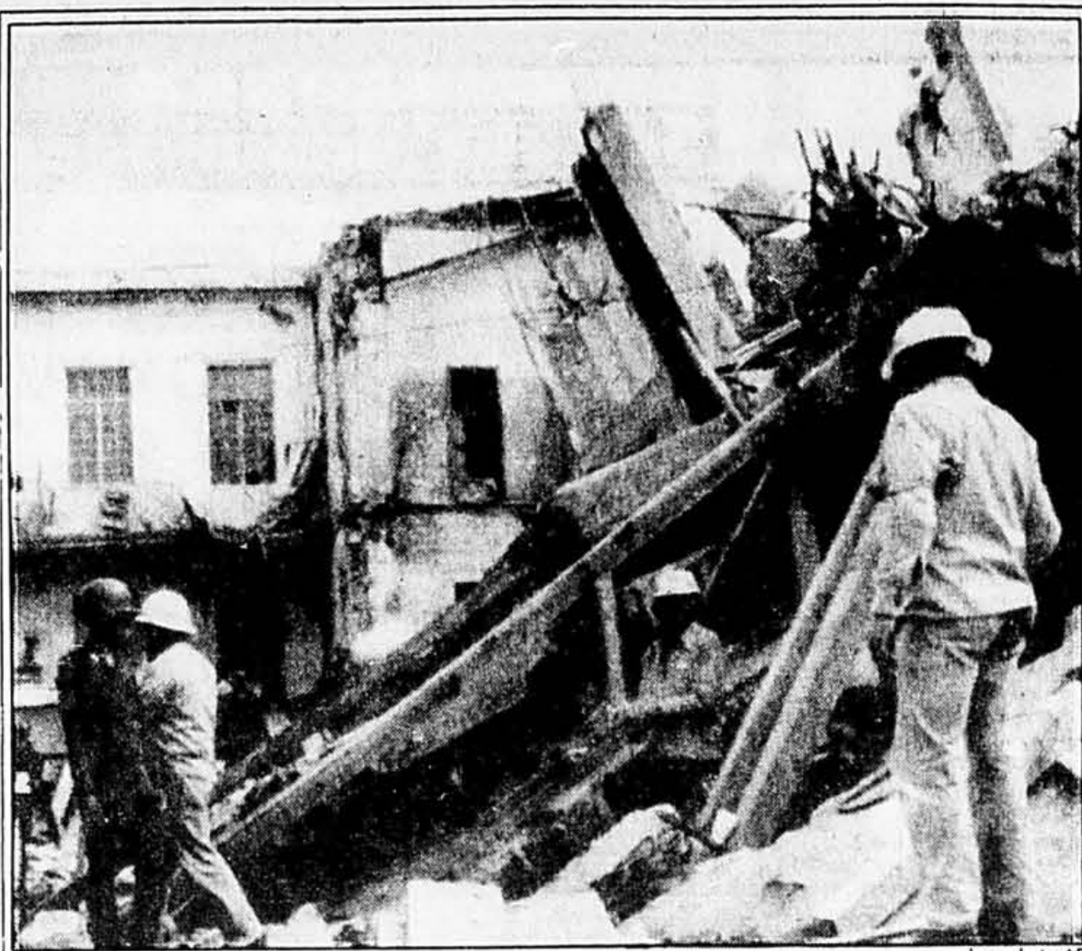
Des secouristes examinent le site d'un édifice détruit lors du tremblement de terre de Mexico tandis que d'autres creusent sous les décombres dans l'espoir d'en sortir un garçonnet de neuf ans qui s'y trouve emprisonné, toujours vivant, depuis plus de deux semaines.
