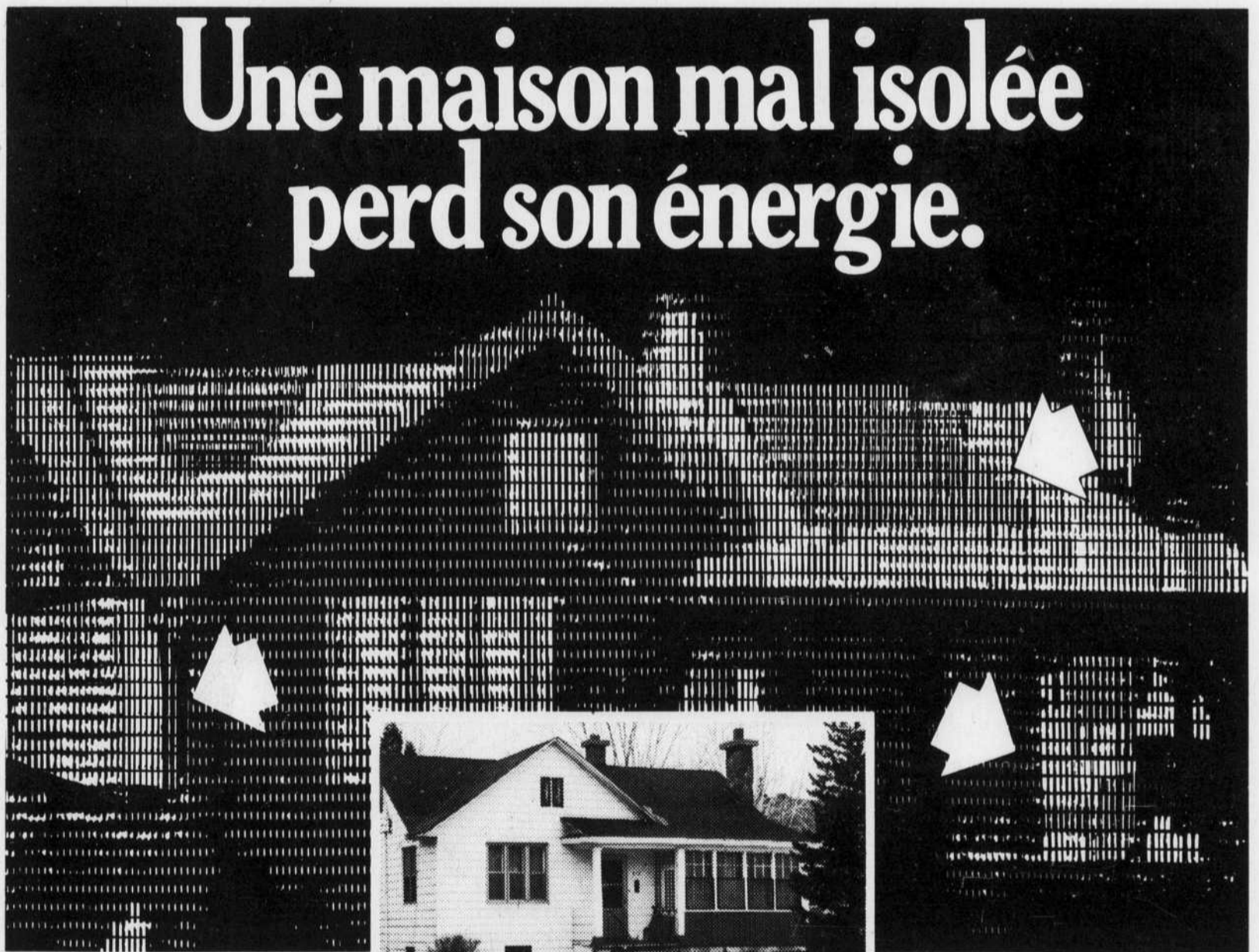
Les flèches montrent les pertes de chaleur.
