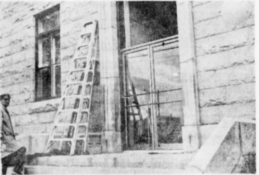
REFECTION A L'HOTEL DE VILLE DE THETFORD MINES — Après la rénovation intérieure de l'hôtel de ville de la cité de Thetford Mines, c'est maintenant l'extérieur qui est transformé par les ouvriers. La photo ci-haut montre le nouveau portique qui vient d'être installé à l'entrée principale de cet édifice public. (Photo La Tribune, Thetford Mines)
