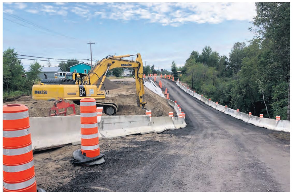
Les travaux de réfections de ponceaux sur le chemin Principal à Pointe-aux-Outardes se poursuivront jusqu'au 16 septembre.
