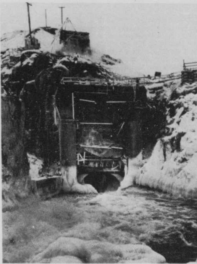
Une vanne d'acier fut descendue hier devant l'entrée de cette galerie de dérivation aux Outardes. L'Hydro-Québec avait tenté, en novembre dernier, d'obtenir la galerie de dérivation principale (de 50 pieds de diamètre et de 1800 pieds de long) creusée en 1945 pour permettre la construction d'un barrage: la technique utilisée, complètement nouvelle, échoua. Les ingénieurs avaient essayé d'obtenir le tunnel en y faisant plonger un bouchon de roc découpé au-dessus de l'entrée, mais l'énorme bloc s'effrita en tombant. On a donc, en un mois, percé une galerie auxiliaire, où les eaux s'écouleront pendant qu'on assèche l'entrée de la galerie principale en y coulant du béton. La galerie auxiliaire a ensuite été fermée au moyen d'une vanne d'acier et l'eau de la rivière a commencé à s'accumuler dans le réservoir. D'une superficie de 250 milles carrés et d'une capacité de 840 milliards de pieds cubes d'eau, ce réservoir alimentera les centrales Outardes 3 et 4, mises en service l'année prochaine.
