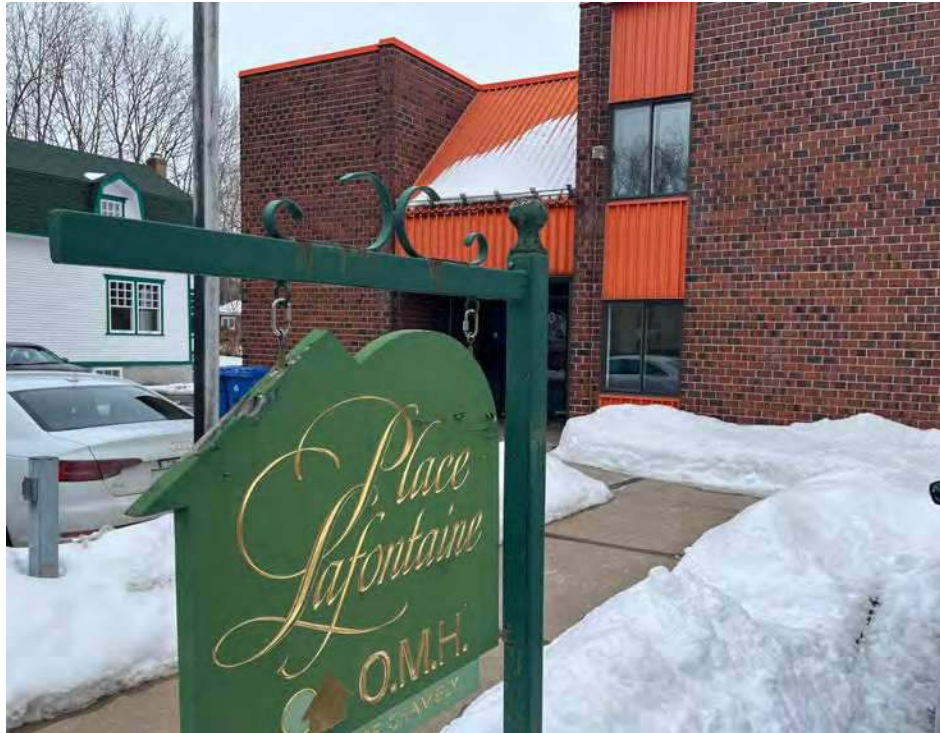
Le bâtiment de la rue Lafontaine est sanctionné d'une cote E. (Photo : Julien Dubois)
