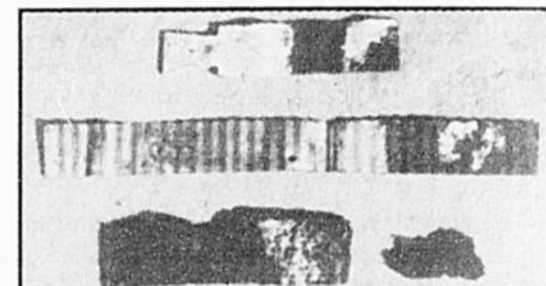
Figure 1.5 Attaches corrodées provenant de murs à placage de brique détériorés à cause de défauts de conception et de construction.
