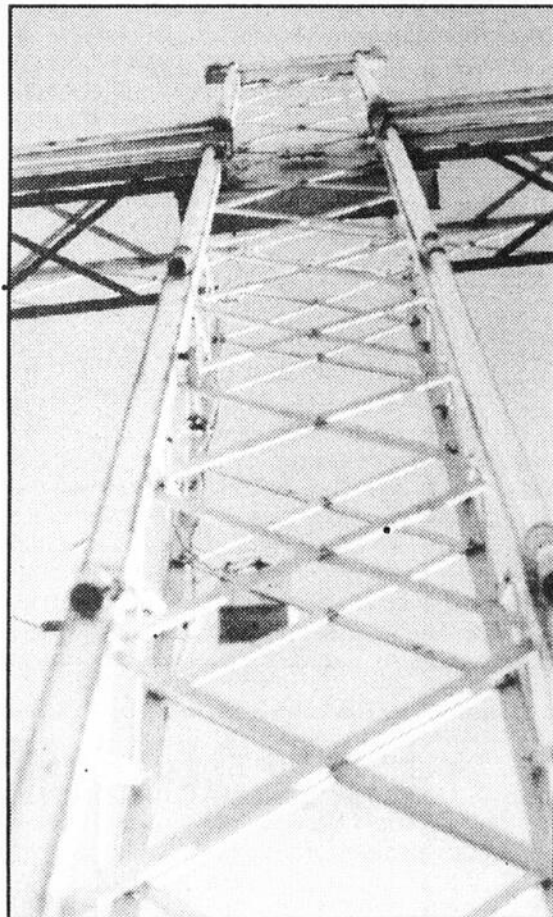
Des néons ont été brisés.
