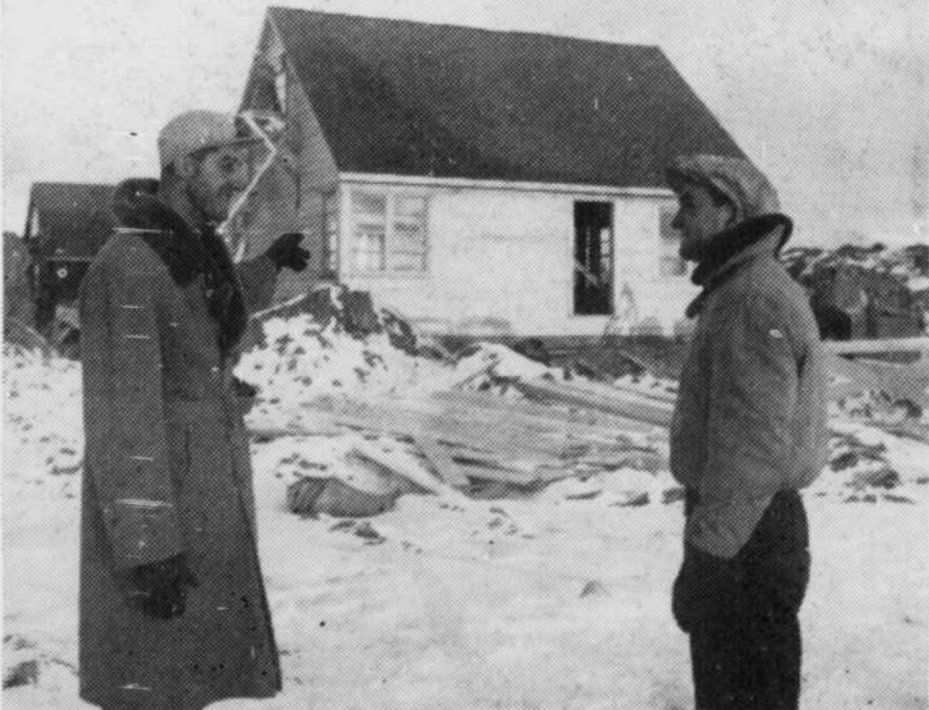
"C'EST LA MIENNE": — Les employés de l'usine d'Alcan d'Isle-Maligne surveillant attentivement les progrès de la construction de leurs maisons. Ils se rendent presque tous les jours sur les chantiers et lorsqu'un détail ne leur plaît pas dans l'exécution des plans, ils consultent l'entrepreneur, qui, désireux de leur donner satisfaction, reçoit leurs remarques avec plaisir. Ci-dessus, deux futurs propriétaires, MM. Yvan Beaumont, à gauche, et Bertrand Duchêne, chefs de section aux salles de cuves 405 et 404 respectivement, au cours d'une de leurs visites quotidiennes. Tous deux ont hâte d'entrer dans leur propriété et que le projet soit complètement réalisé. "Nous vivrons alors réellement en famille", expliquent-ils.
