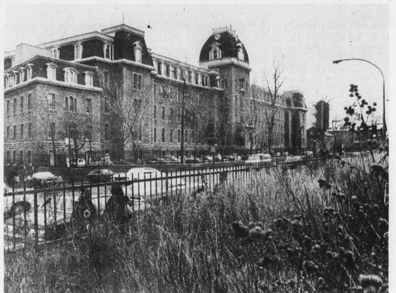
L'immeuble du collège Mont-Saint-Louis, sur la rue Sherbrooke, est typique des maisons d'enseignement de la fin du XIXe siècle. (Photo Jacques Grenier)
