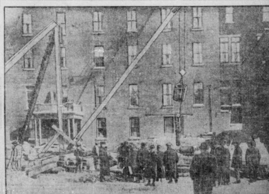
La vignette ci-dessus représente les premiers travaux d'excavation à l'endroit où sera construite la nouvelle gare du Canadien Nord, à l'angle des rues Cathcart et Saint-Monique. On voit une puissante grue à vapeur en train d'enlever la terre sur l'emplacement où se voyait l'ancien hôtel "Turkish Bath". Les travaux viennent de commencer et seront poussés très activement. Cliquez du photographe de la "Tribune".
