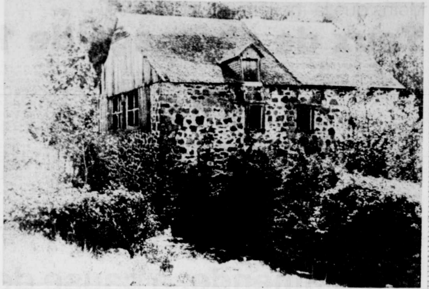
Construit en 1823, le moulin de L'Isle-Verte a besoin de réparations pour empêcher une plus grande détérioration.
